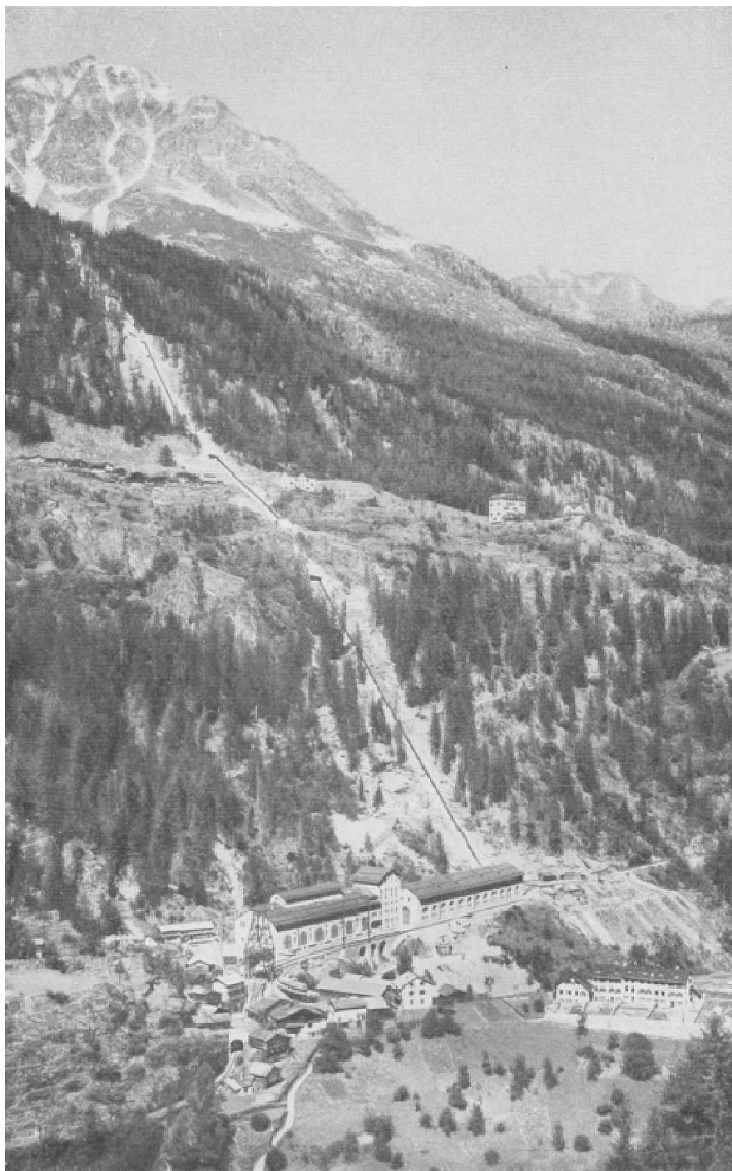
Európa első szivattyús tározója, Svájc, 1923
